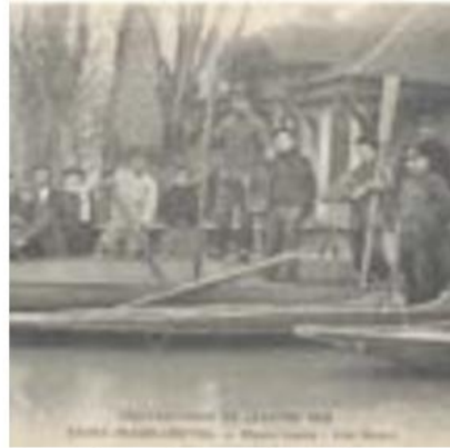
La maison Camus lors des mêmes inondations. Le quartier Schaken a été totalement submergé.
